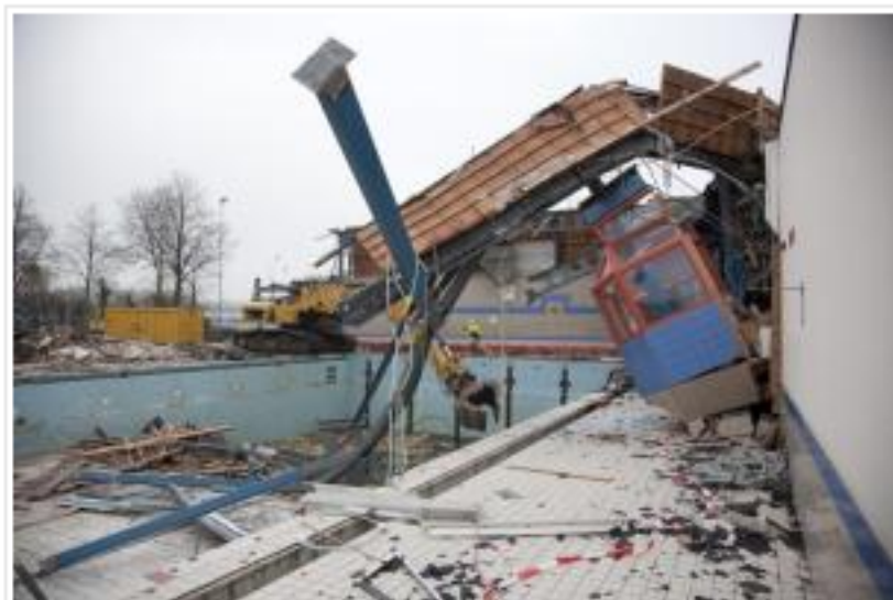
Sloop van zwembad De Honte in Terneuzen. Zwemliefhebbers kunnen sinds eind 2005 in De Vliegende Vaart terecht. foto Mark Neelemans
